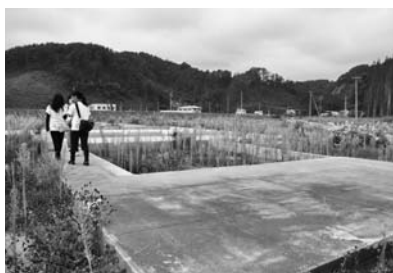
流された保育所の基礎部分
